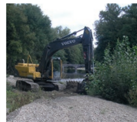
Retrait de la végétation sur les bancs
